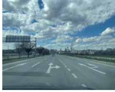
Kentin kuzey yönünde bulunan fabrika alanı
