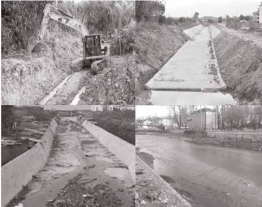
Şekil 4. Düzce kent merkezi ve civarında yapılan dere ıslahı çalışmaları
